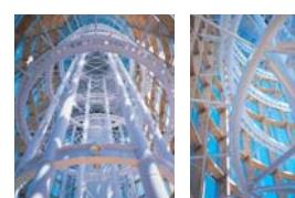
此構造稱張拉整體 (Tensegrity) 結構、看起來既像鐵塔又像琉璃塔、非常獨特。該塔大量使用鳥取縣日南町的杉木集成材、以柔和、溫暖的氣氛歡迎八方來客。
